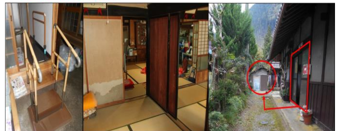
敷居が高い 和室続きの間取りで、手すりを設置することが難しい 外風呂・外トイレに行くのに不整地を通る
