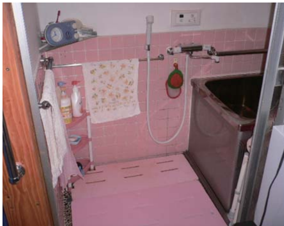
写真6 浴室内の手すり設置
