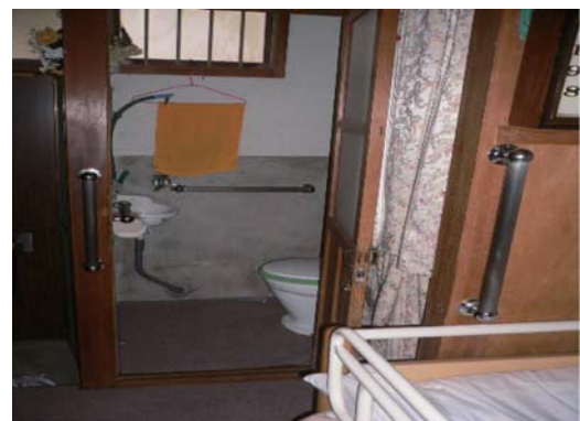
写真4 トイレ周囲の手すり設置
