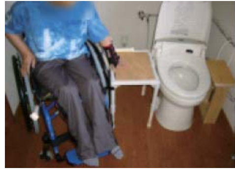
図2. トイレの改修
