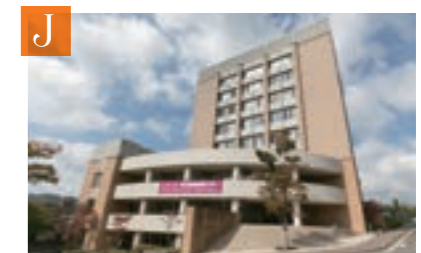
J 10号館 地上地下、計9フロアを有する10号館。入院病棟をリアルに再現した実習室などを整備し、より臨床現場に近い環境で学ぶことができます。
