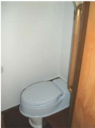
写真8 改修後のトイレ
