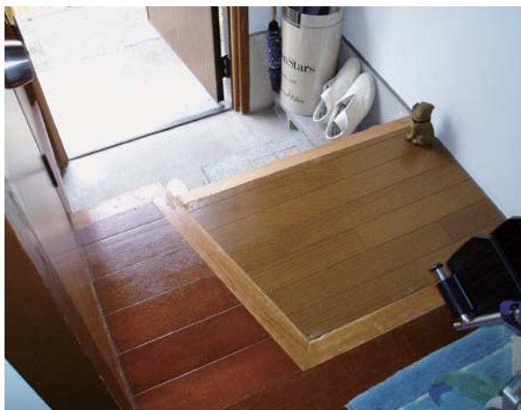
写真9 改修後のトイレ前廊下
