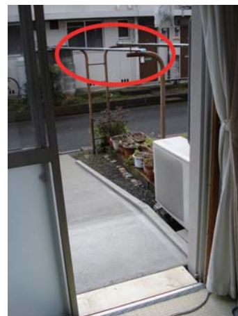
写真11 改修後出入り口
